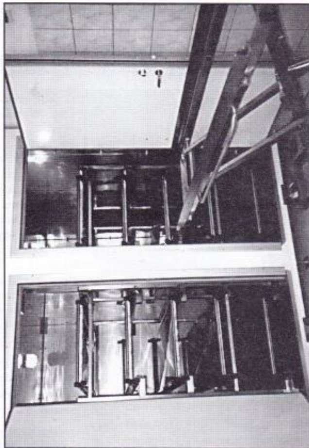
Komora chłodnicza w systemie regałowym na 10 ciał na tacach. Transport przy użyciu wózka hydraulicznego.
